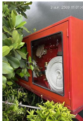
ตู้เก็บสายฉีดน้ำดับเพลิง
