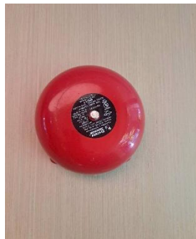
สัญญาณแจ้งเหตุแบบกริ่ง
