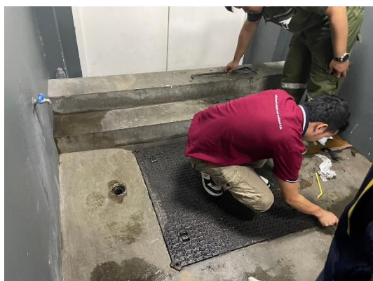
ตะแกรงดักมูลฝอยก่อนระบายออกนอกโครงการ
